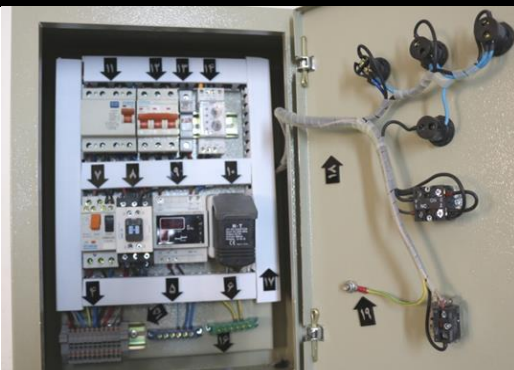
تابلو برق سه فاز الکتروموتور
